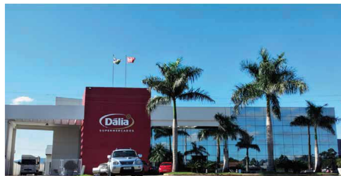
Supermercado Dália localizado em Arroio do Meio /RS
