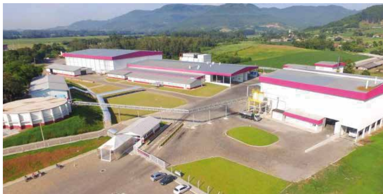
Instalações do frigorífico de aves localizado em Arroio do Meio/RS
